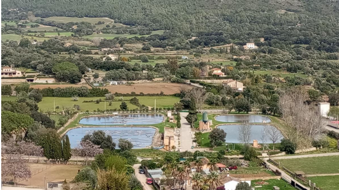
Una imagen de la estación depuradora de Artà. / Caib
